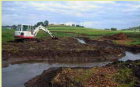
Anlage des neuen Betts der Seekircher Aach / New, raised river bed of the Seekircher Aach
