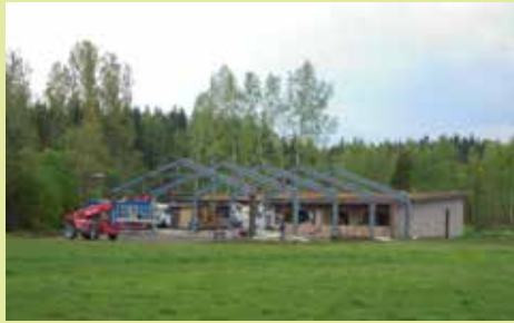
Abbruch Gebäude / Demolition of the building
