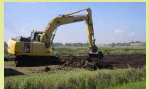
Abschieben der obersten vererdeten Torfschicht / Pushing off the earthy soil
