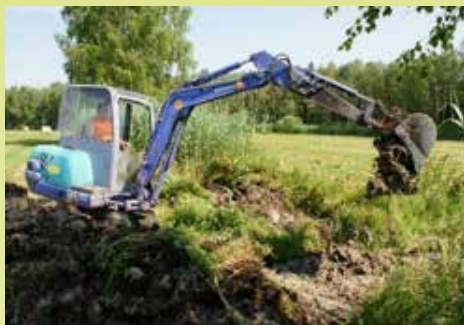
Grabenverschluss / Ditch closure
