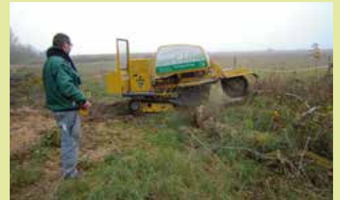
Fräsen der Baumstumpen / Cutting of tree stumps
