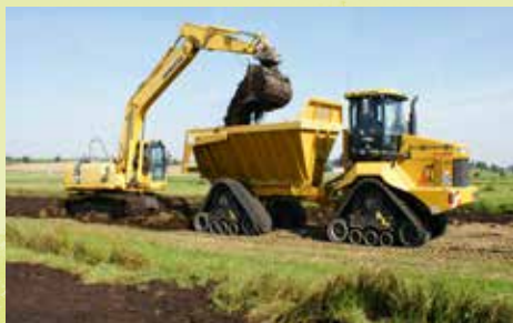
Verfüllung von 30 km Gräben / Filling of 30 km of ditches
